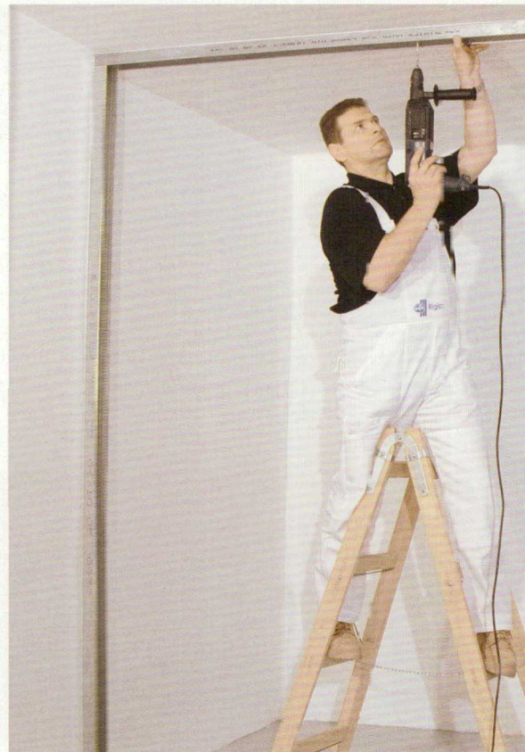
A válaszfal tartószerkezetének szerelése – határoló profilok (vízszintes UW, függőleges CW)
