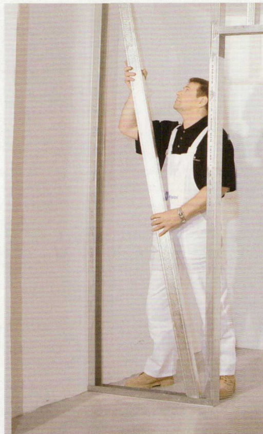
Válaszfal tartószerkezetének szerelése – függőleges CW-profilok
