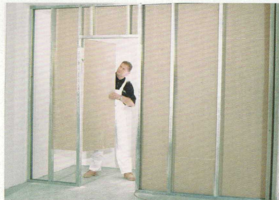
Falborítás szerelése – a válaszfal egyik oldala
