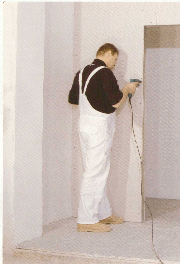
Falborítás szerelése – a válaszfal másik oldala
